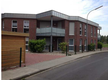
Abbildung 14: Mehrgenerationenwohnen an der Wallstraße
