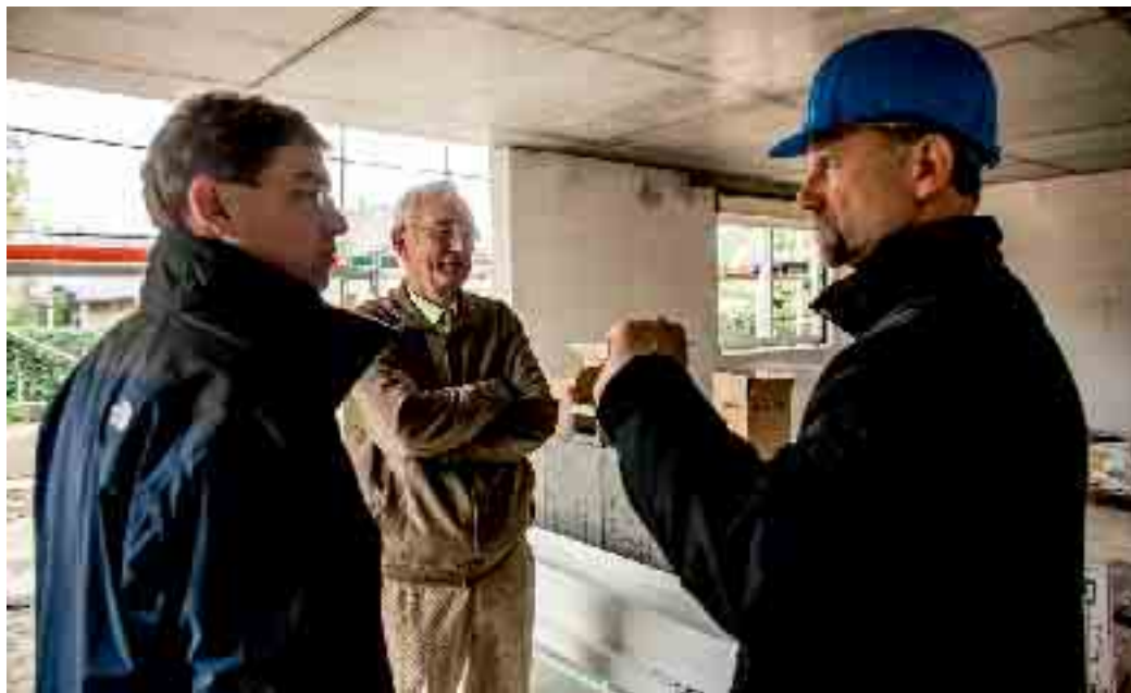
Qualitätskontrollen helfen dabei, Rechtsstreitigkeiten wegen Mängel beim Bau eines Hauses zu vermeiden. Foto: djd/Bauherren-Schutzbund
