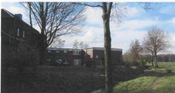
Ost-Ansicht auf Anbau und Turnhalle
