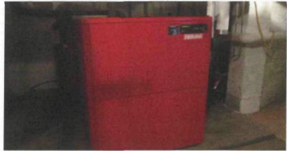
700 l Warmwasserbereitung Baujahr 1997
