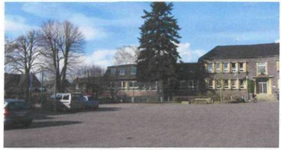
westlicher Anbau der Grundschule mit ausgebautem Dachgeschoss
