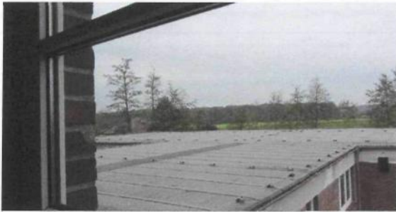
Sanierte Flachdachfläche auf Anbau und Turnhalle
