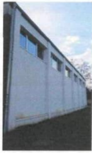
Nord-Fassade der Turnhalle
