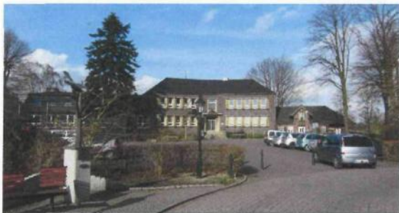
Süd-Ansicht mit Haupteingang (eingetragen als Baudenkmal)
